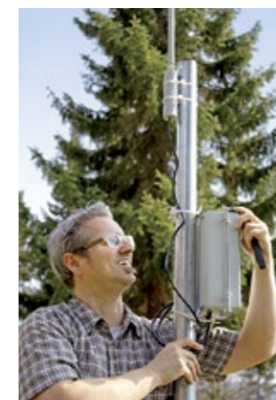
Frank Schlesok montiert die Anlagen selbst und optimiert jeden Hotspot.
